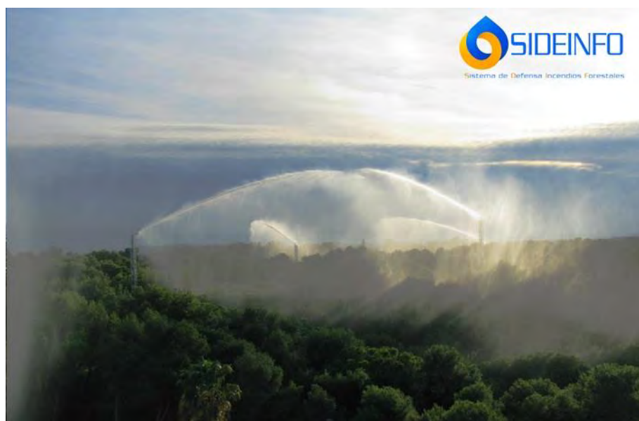
Imágen 47. Ejemplo de sistema de Defensa Activa (SIDEINFO) implementados en Torrent. Fuente: MEDI XXI GSA.
